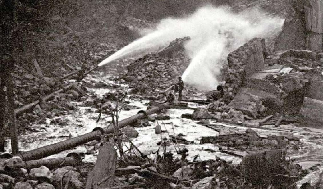
USO DE JATO D'ÁGUA NA DERRUBADA DO MORRO DO CASTELO Fotografia de Augusto Malta, Acervo IMS, 1928.
