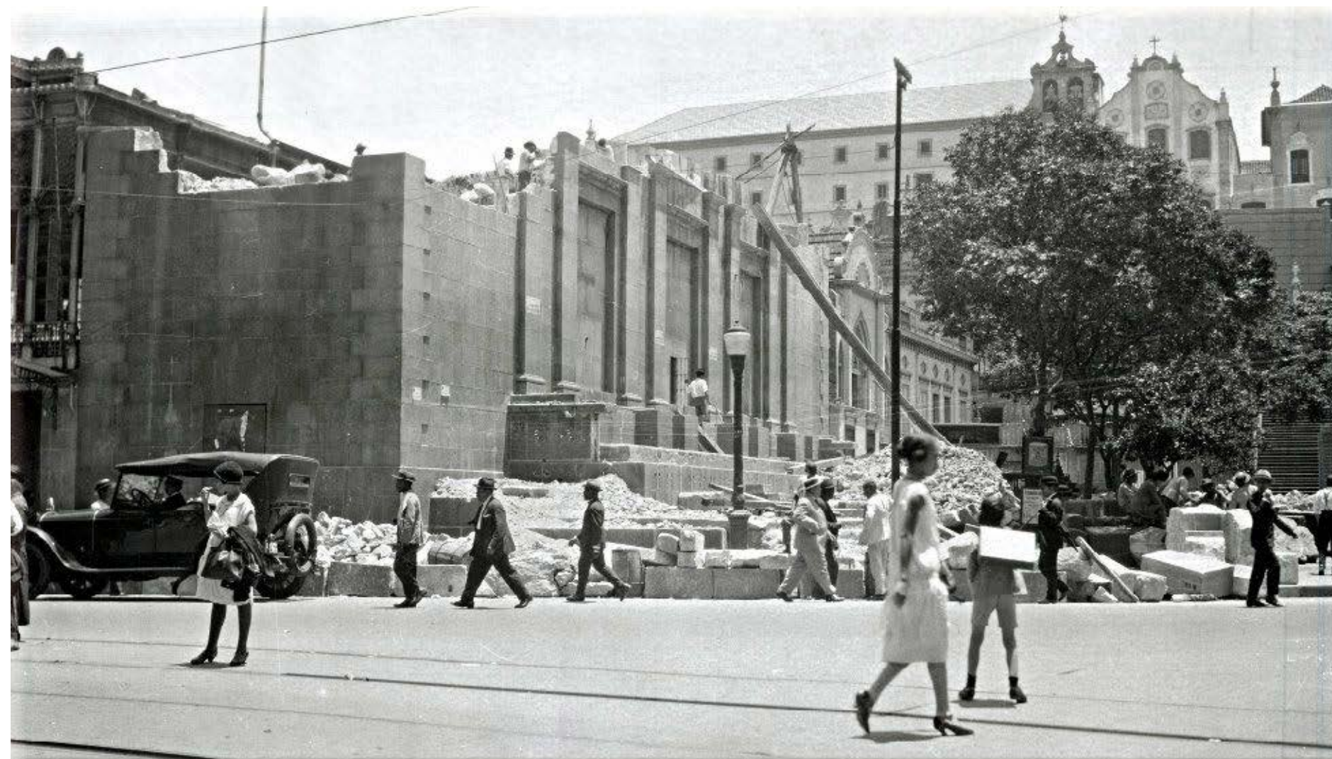
Demolição Chafariz da Carioca Fotografia por Luciano Ferrez. Arquivo Família Ferrez, 1925.
